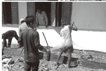
빗물받이 콘크리트 공사에 참여한 주민들
