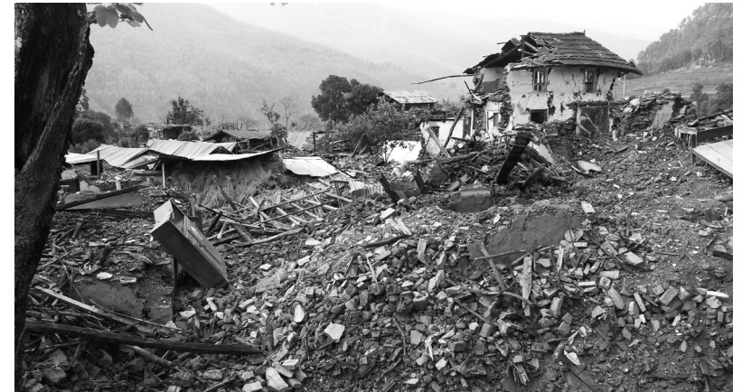
지진으로 무너진 주택. 산간에 벽돌로 지은 집이 많이 피해가 컸다.
