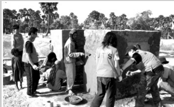
두르가푸르 유치원 사위장 공사
