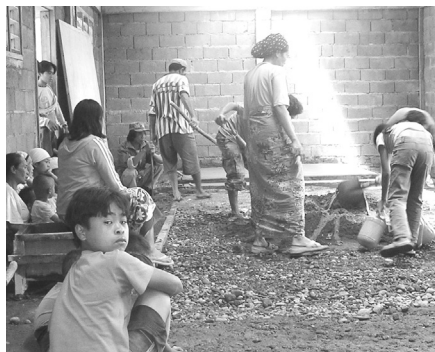
▲ 학교건축 공사에 손 보태는 주민들
