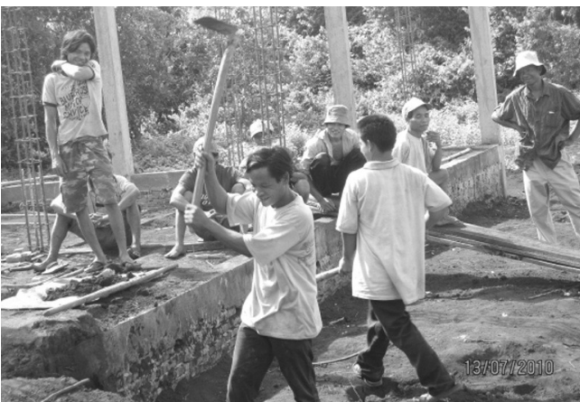
주민참여가 활발한 툰 마을 학교 공사 현장
