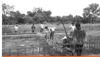
타뱅크로움 공사 현장에 나와 학교 짓는 주민들
