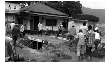
우바 마을 관개수로 공사현장
