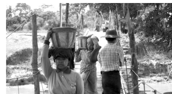
탄터빈 마을 공사 현장에 자갈과 모래를 운반하는 주민들
