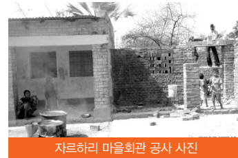
자르하리 마을회관 공사 사진
