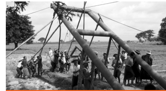
삐예지 다리 타워 공사 작업에 참여한 마을 주민들
