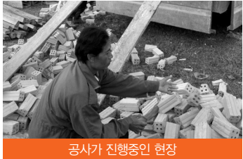
공사가 진행중인 현장
